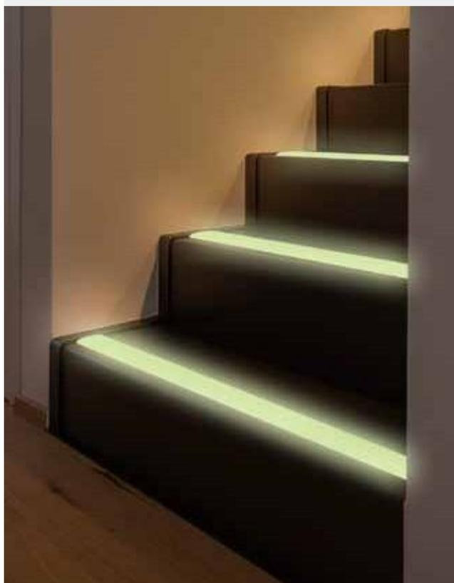
**Il profilo di raccordo fosforescente M65** permette una buona visibilità anche in luoghi dalla scarsa luminosità, facilitando il passaggio.
